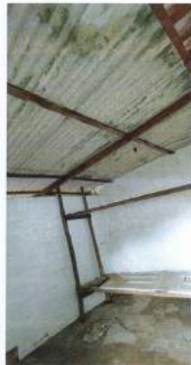
Foto 05 – Demonstra parte coberta por telha de fibrocimento.
