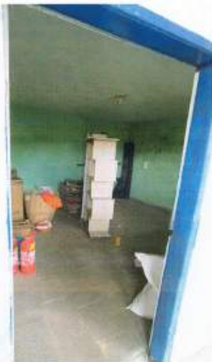
Foto 06 – Demonstra parte com forro em laje.
