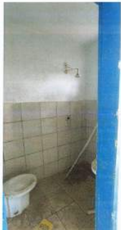
Foto 04 – Demonstra banheiro da construção.
