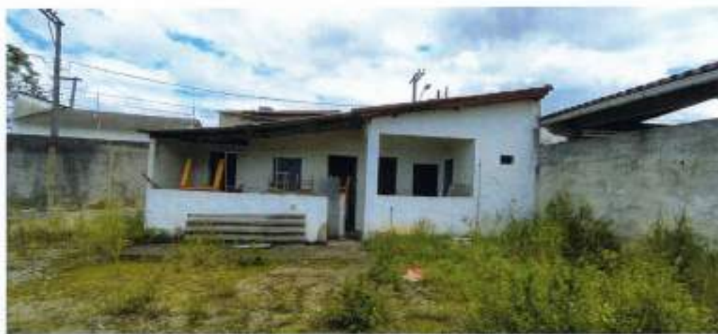
Foto 03 – Demonstra construção no interior do terreno.
