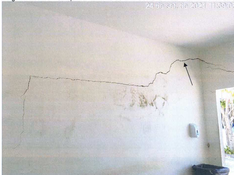
Foto 04: Surgimento de trinca após a reforma do ano de 2018 vista internamente da edificação
