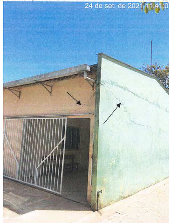
Foto 07: Surgimento de trinca após a reforma do ano de 2018 vista externamente da edificação
