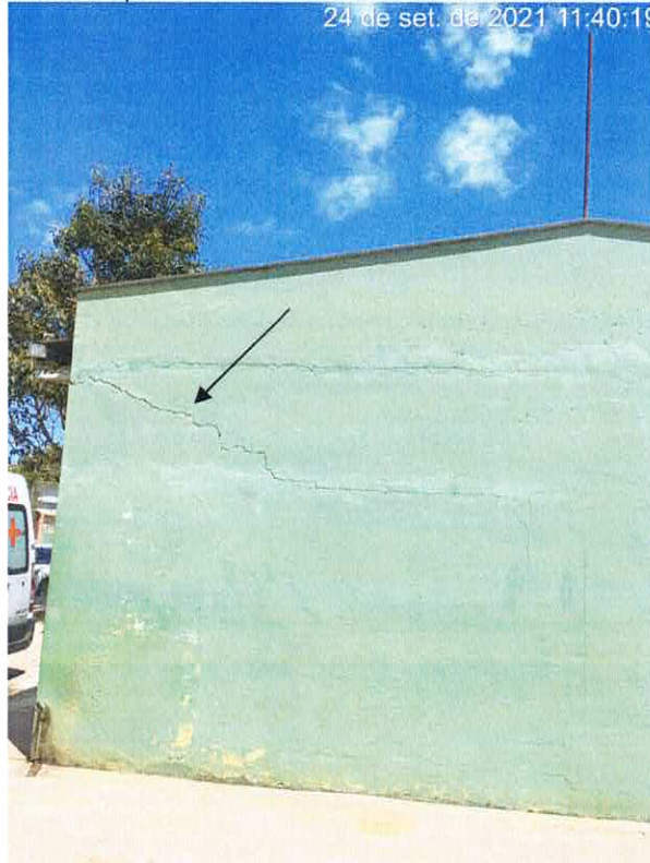
Foto 07: Surgimento de trinca após a reforma do ano de 2018 vista externamente da edificação
