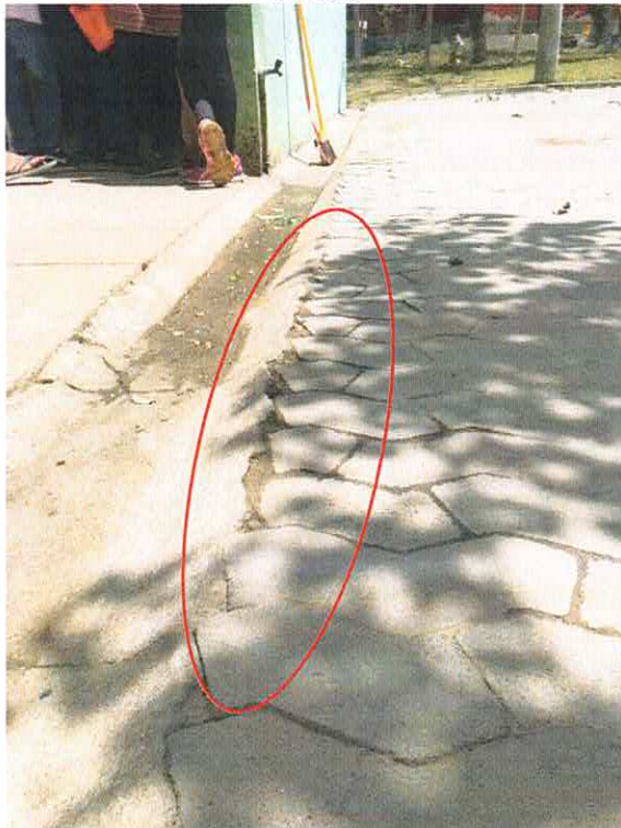
Foto 10: Calçamento externo recalcando (deformando) próximo a parede que apresenta fissuras e trincas
