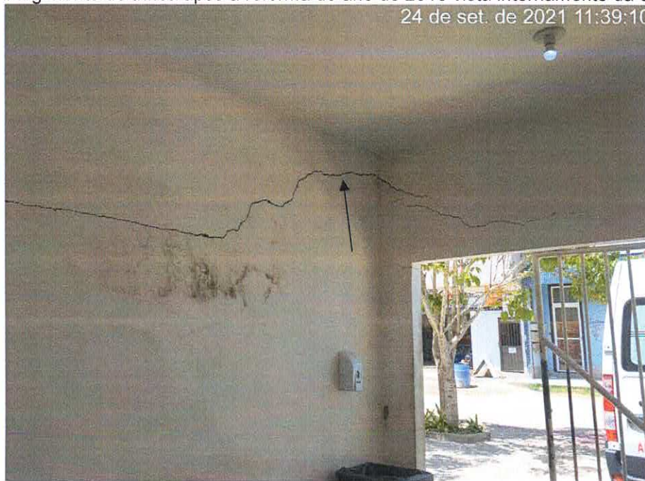
Foto 03: Surgimento de trinca após a reforma do ano de 2018 vista internamente da edificação
