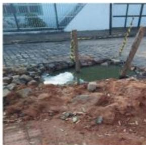
Conforme se verifica na imagem acima, o bueiro – localizado em frente à EEEM Nair Miranda se encontra entupido, e a pavimentação da via se mostra cedendo
