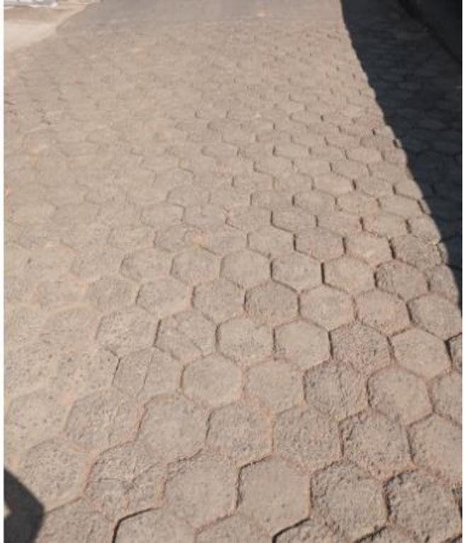
Nas imagens acima colacionadas, percebe-se que além dos espaçamentos existentes entre os blocos, temos ainda um enorme desnível na parte lateral, próximo à calçada, com um pequeno trecho de asfalto.
