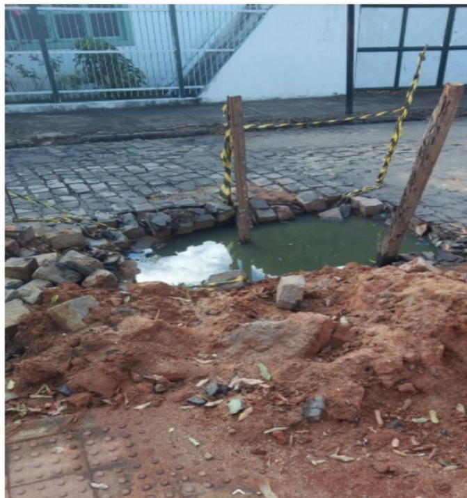
Conforme se verifica na imagem acima, o bueiro – localizado em frente à EEEM Nair Miranda se encontra entupido, e a pavimentação da via se mostra cedendo
