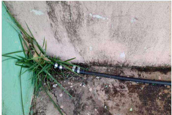
Além da mangueira, que necessita ser instalada corretamente, verifica-se a presença de muita umidade e mofo nas paredes do consultório, necessitando assim de remoção, emboço e nova pintura.
